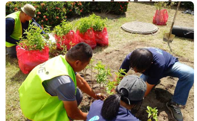
后里能資源中心友善蜜源植物種植施工狀況
